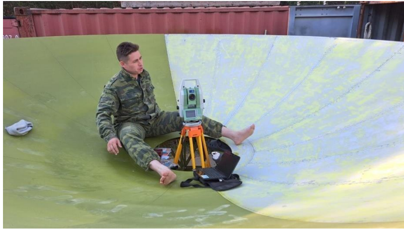
Геодезические измерения. Подготовка к установке опор контррефлектора
