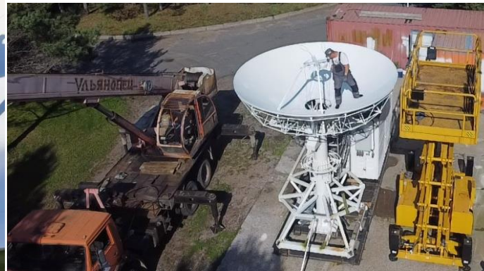
Монтаж зеркальной системы на ОПУ
