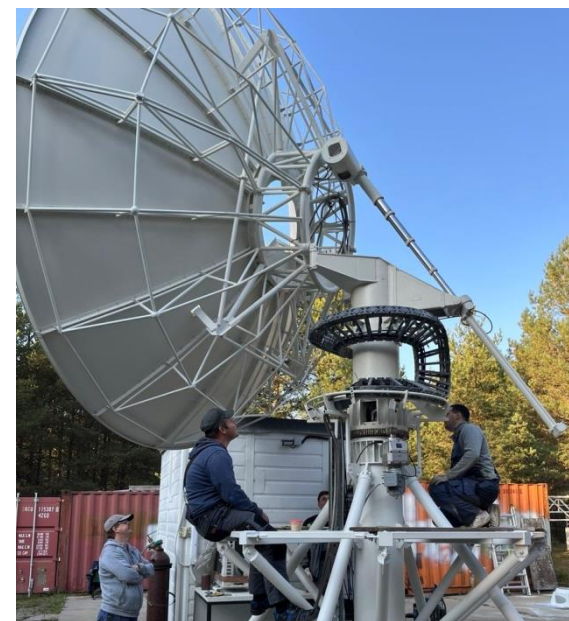
Монтаж на антенне
