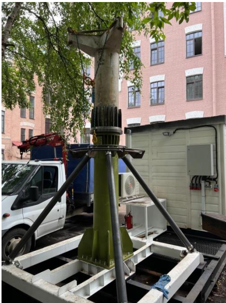
Предварительная сборка ОПУ TESLA
