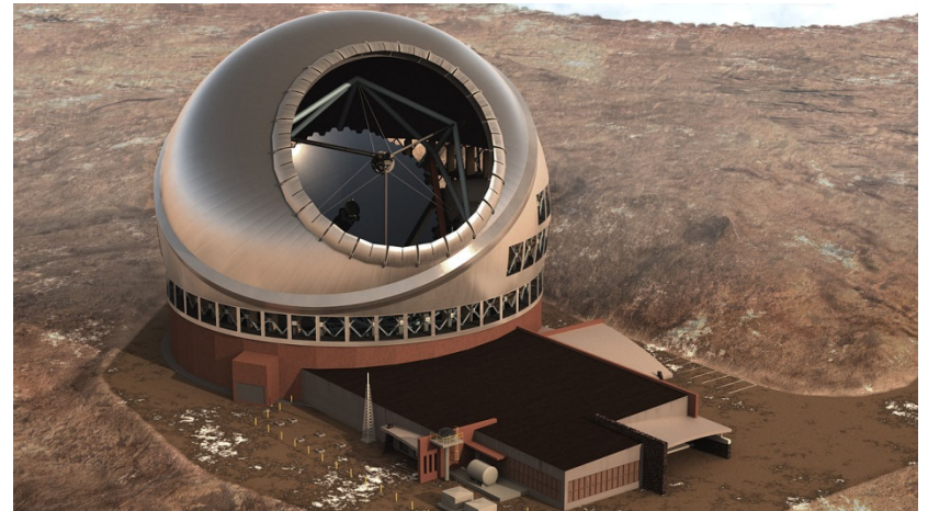
Thirty Meter Telescope, Мауна Кеа, Гавайи (2027) D = 30 м, 492 сегмента (1,4 м)
