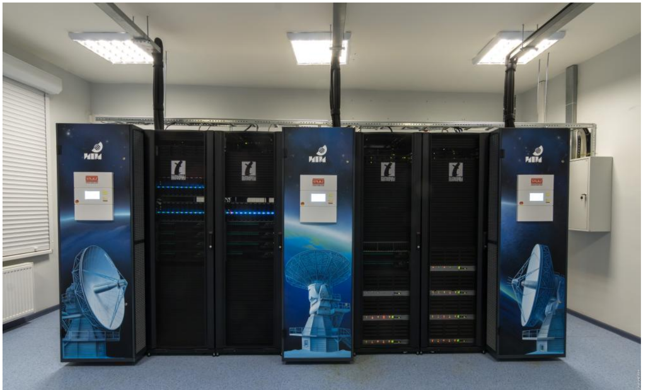
Рис. 1.3. Вычислительный кластер Программного коррелятора. Крайние и центральная стойки (3 шт.) — кондиционеры, между ними — 4 вычислительных стойки.
