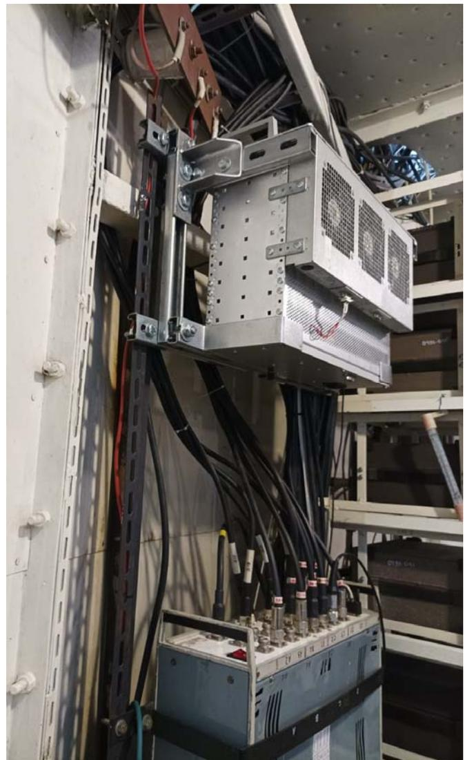
Рис. 7. Опытный образец МСПС в надзеркальной кабине РТ-32 обсерватории «Светлое»
