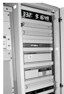
Рис. 6. а — наземные и антенные модули блока опорных частот; б — стойка формирования и распределения опорных сигналов
