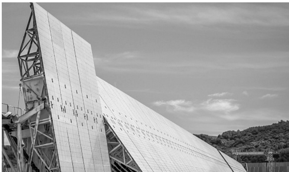
Рис. 1. Перископический (плоский) отражатель радиотелескопа РАТАН-600
